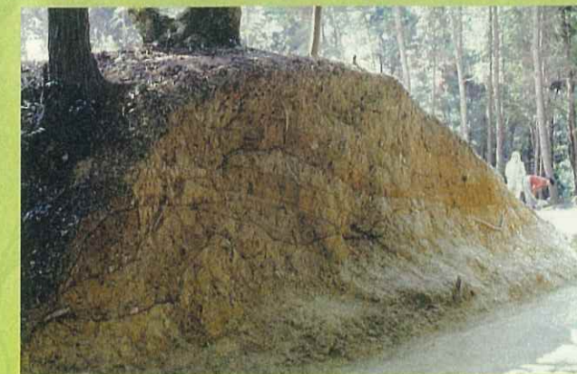
⑧二の曲輪土塁 曲輪を平坦に造成した際の廃土が硬く積み重ねられていました。土塁を挟み、二の曲輪よりも三の曲輪が2m程低い、段違いの地形です。
